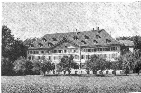
Das Fellenberghaus in Hofwil, Gesamt-Seminargebäude 1884 bis 1905, seither Unterseminar.
