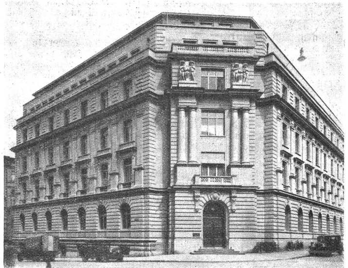
Das Telegraphengebäude in Bern nach erfolgtem Um- und Aufbau.
