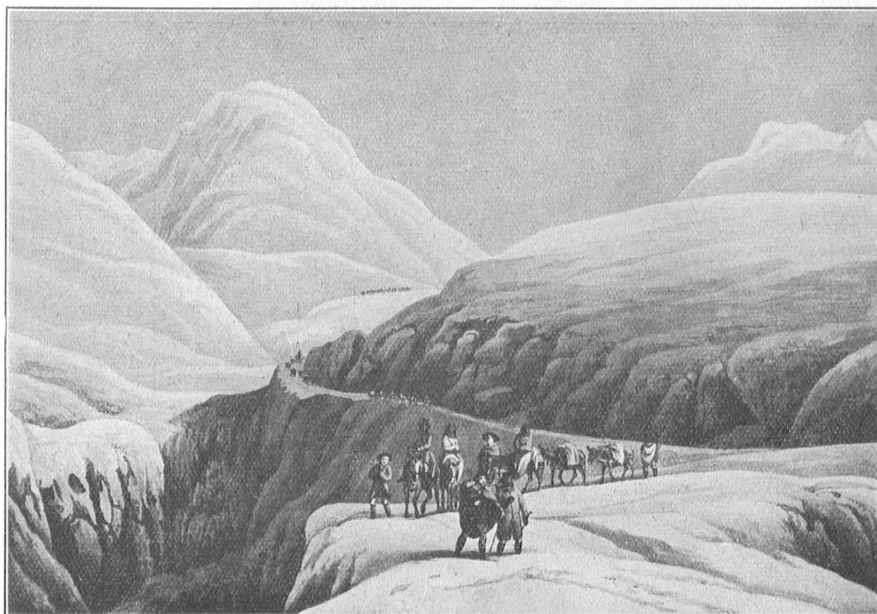
Die Gotthardstraße um 1800.
