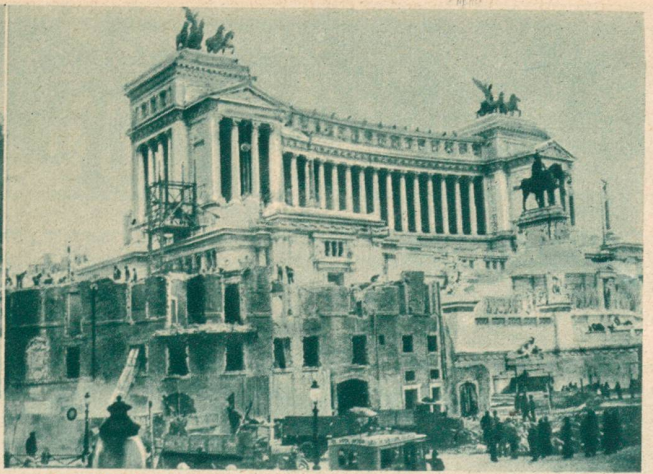
Das alte Rom wird abgerissen zur Anlage einer großen zentralen Verkehrsader. Zwischen der Piazza Venezia und dem Kolosseum werden alte Häuserblocks abgerissen.
