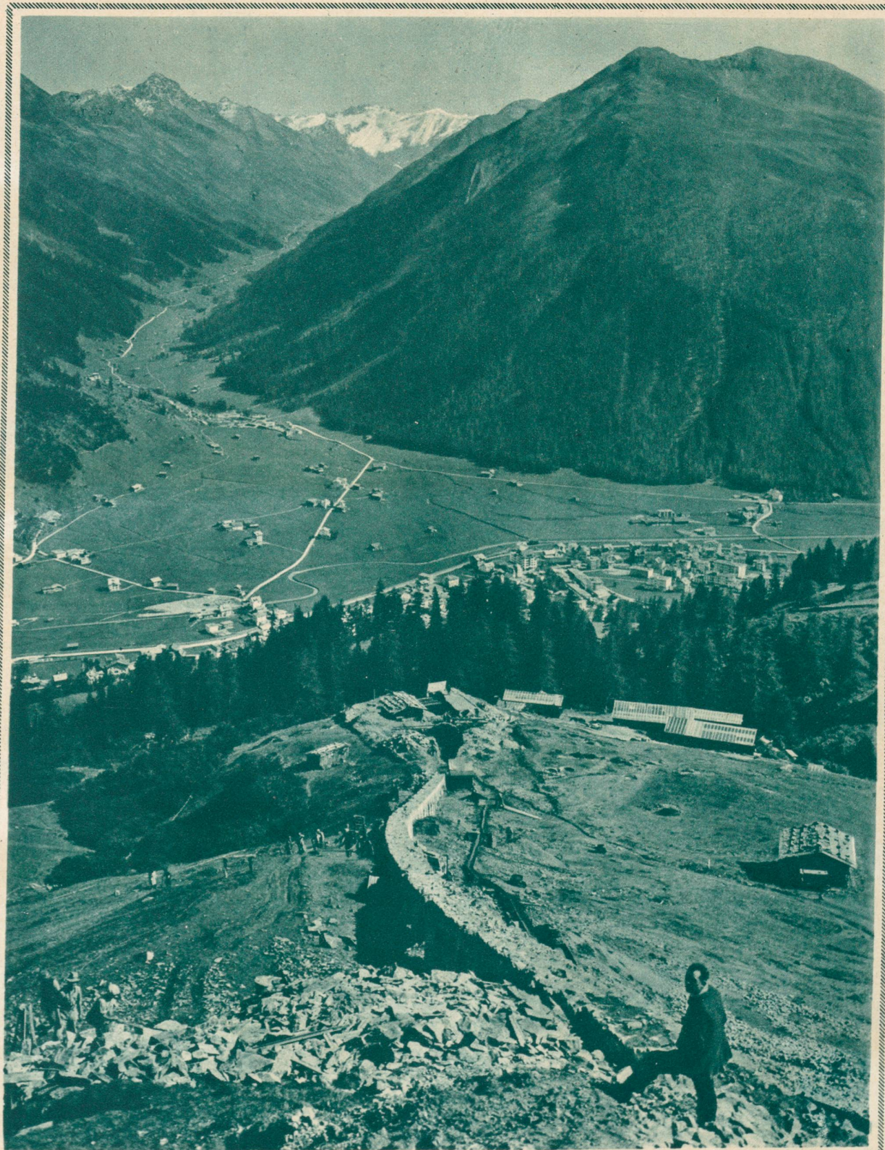
Der Bau der Parsennbahn
