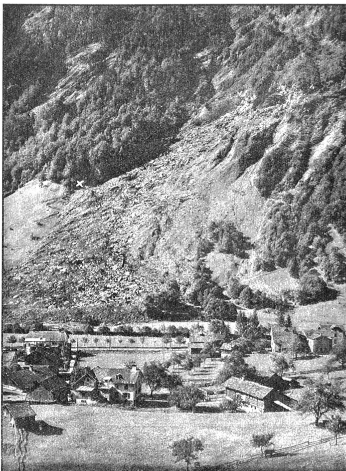
Vom Bergsturz in Engi (Kt. Glarus). — Phot. Krenn, Zürich. Blick von der rechten Calteite auf das ganze Abbruchgebiet. Im Vordergrund Häuser von Engi. Die mit einem X bezeichnete Stelle zeigt den Eingang zum Schieferbergwerk.
