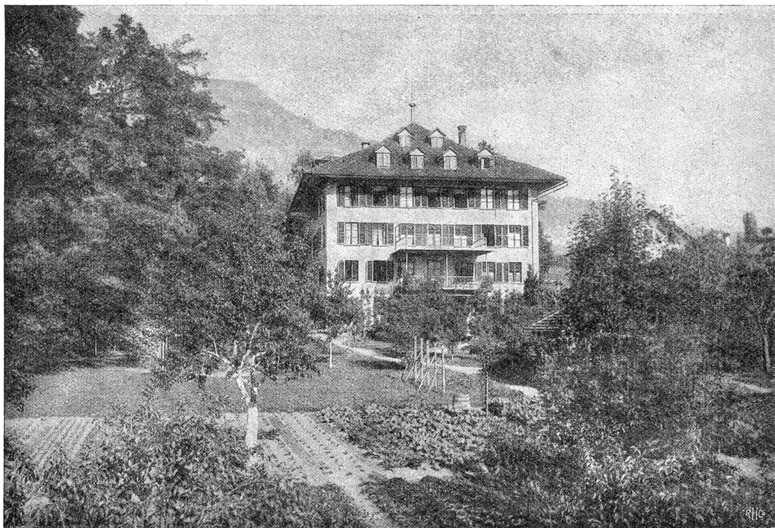
Die kantonale Alpwirtschafts- und Haushaltungsschule in Brienz. Das Schulgebäude mit Garten (Ansicht von Süden).
