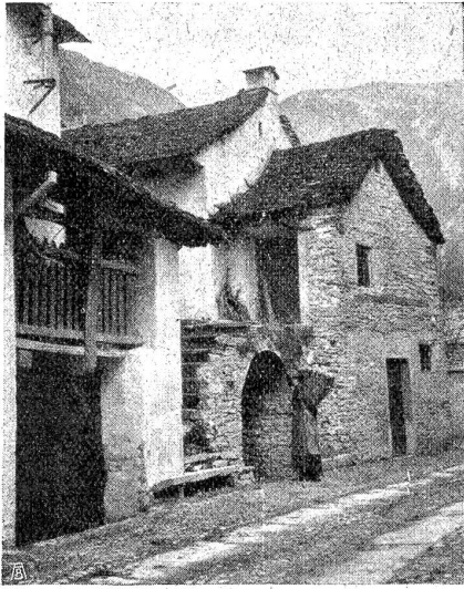
Cossiner Steinhaus mit Steinplattendach. (Cegna bei Locarno.)
