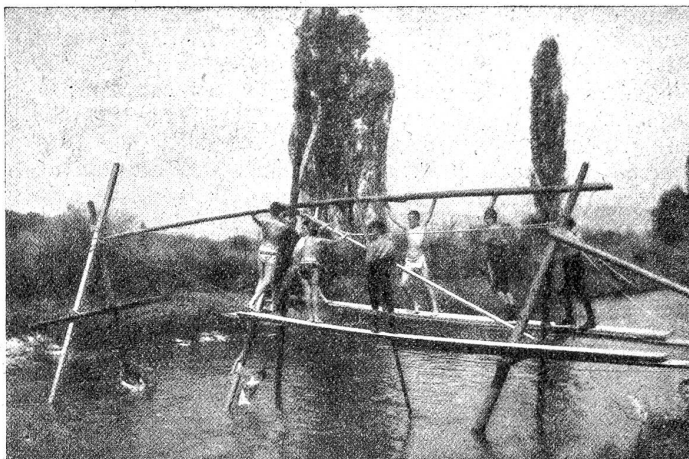
Pfadfinder beim Brückenbau.
