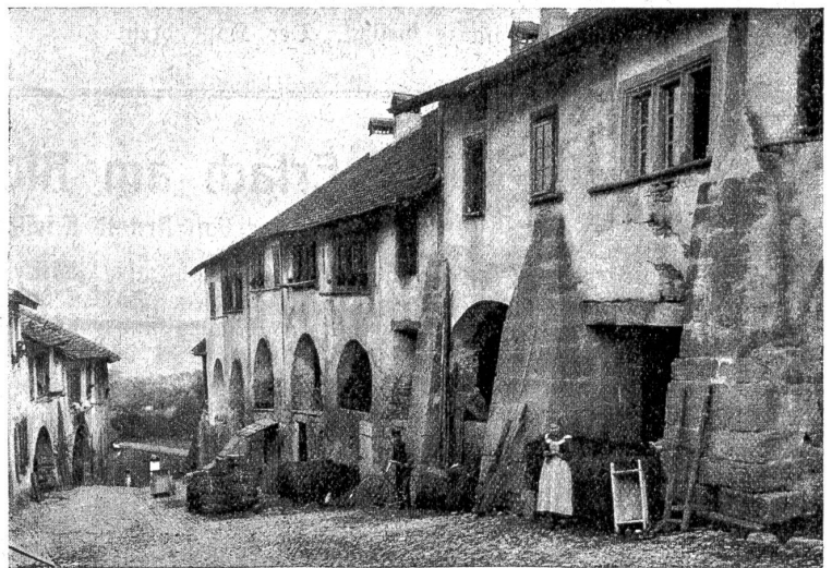
Erlach: Rückblick aus dem obern Teil der Altstadt. (Südseite rechts ist abgebrannt.)
