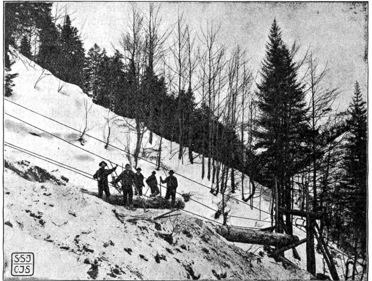
Eine sog. Seilriesen-Anlage. Mittelft des Drahtseils werden die geschlagenen Holzstämme zu Tal gefördert.
