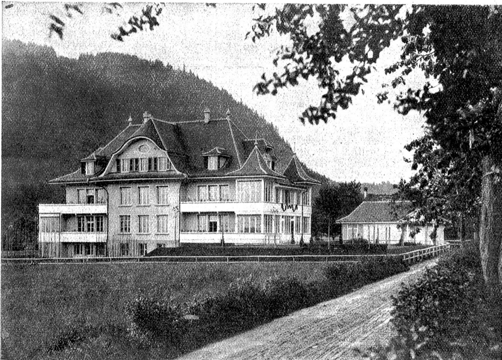
Das neue Krankenhaus in Oberdiessbach.
