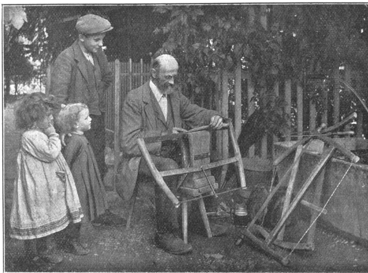
fahrendes Volk: Der Sägefeiler, der mit seinem Bock die Dörfer durchzog und von Haus zu Haus auf der „Stör“ die Sägen wieder scharf machte.
