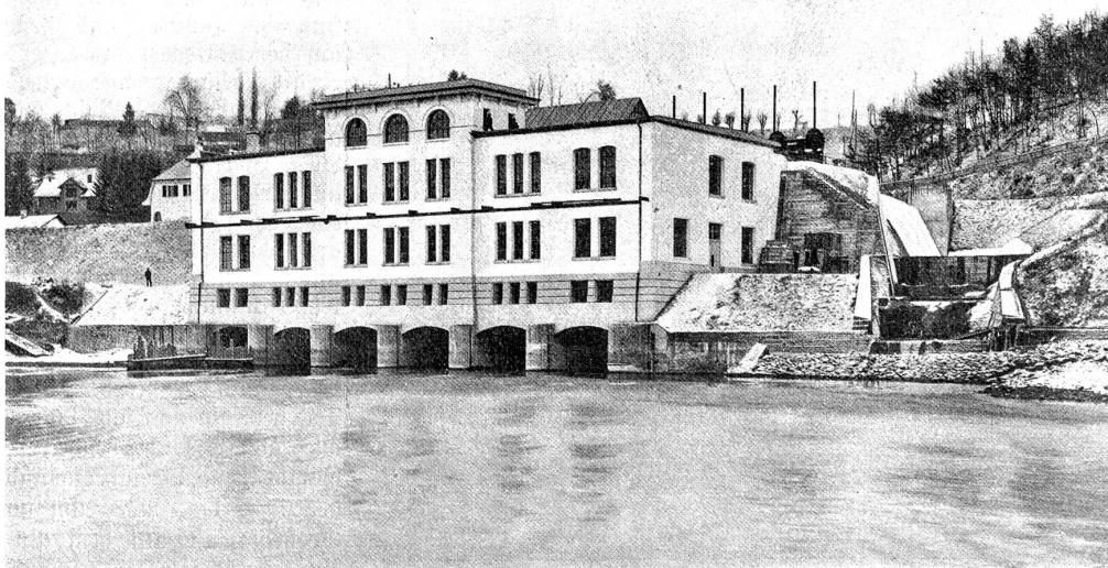
Das Elektrizitätswerk in der Felsenau bei Bern.
