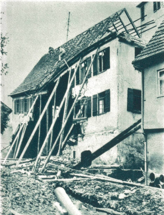
Schulhauseinsturz in Württemberg.
