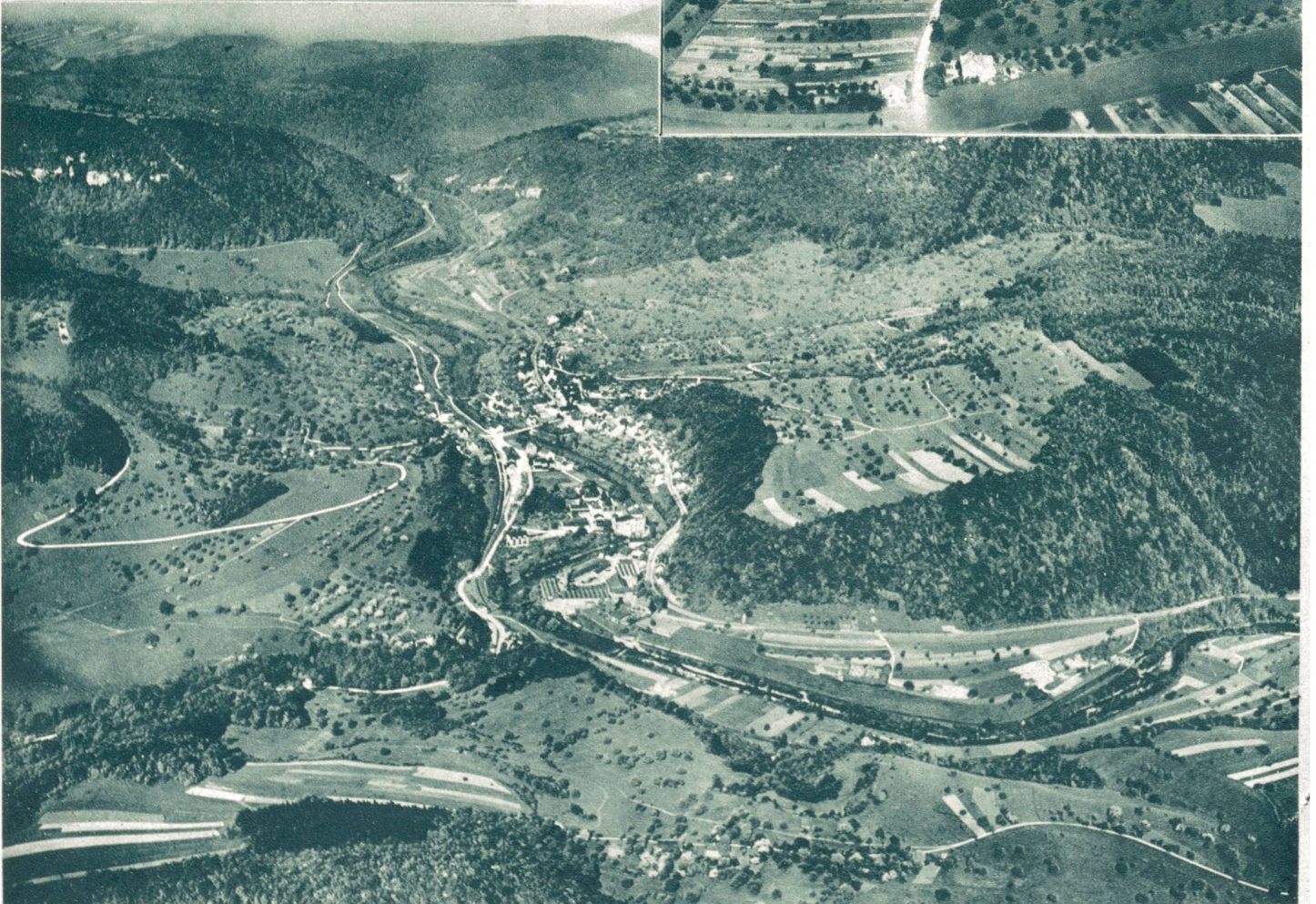
Fliegeraufnahme des Dorfes Grellingen aus 900 Meter Höhe. Oben rechts das Dorf Röschenz bei Laufen aus 400 Meter Höhe. Photos Ad Astra-Aero, Zürich.
