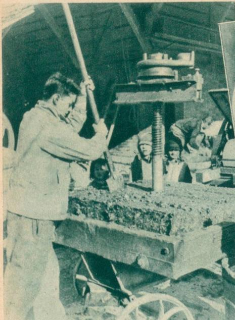
Zerschneiden der Trester auf der Presse, um nochmals gepreßt zu werden.
