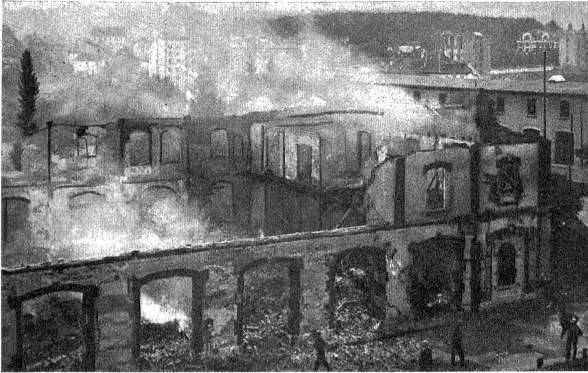
Vom Zeughaus-Brand in Freiburg. — Das abgebrannte Hauptgebäude.
