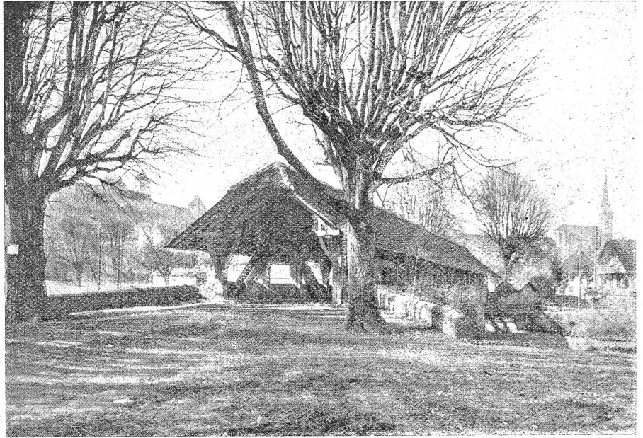
Die Wynigenbrücke bei Burgdorf.
