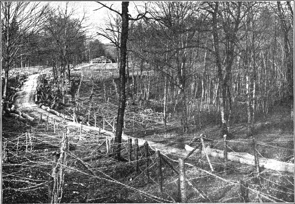
An unserer Grenze: Blockhaus mit davor liegenden Drahthindernissen.
