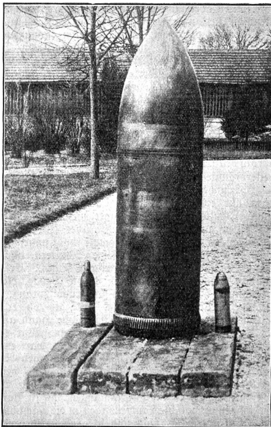
Ein 42-cm Geschöß der deutschen 42-cm Mörser, welches ohne zu krepieren, niedergegangen ist. Daneben steht ein französisches 7,5-cm Geschöß.
