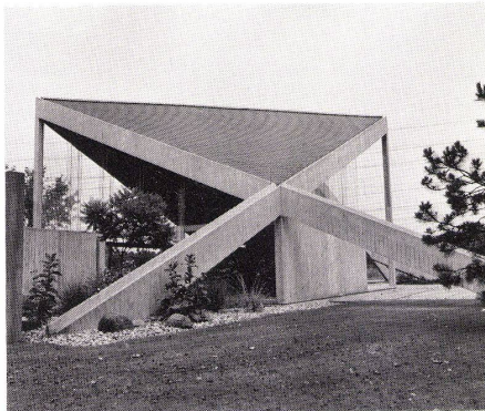
4 Nord-Ostansicht mit Eingangsfront und Dienstgebäude. Vue nord-est montrant l'entrée et le bâtiment de service. Northeast elevation view with entrance and service building.
