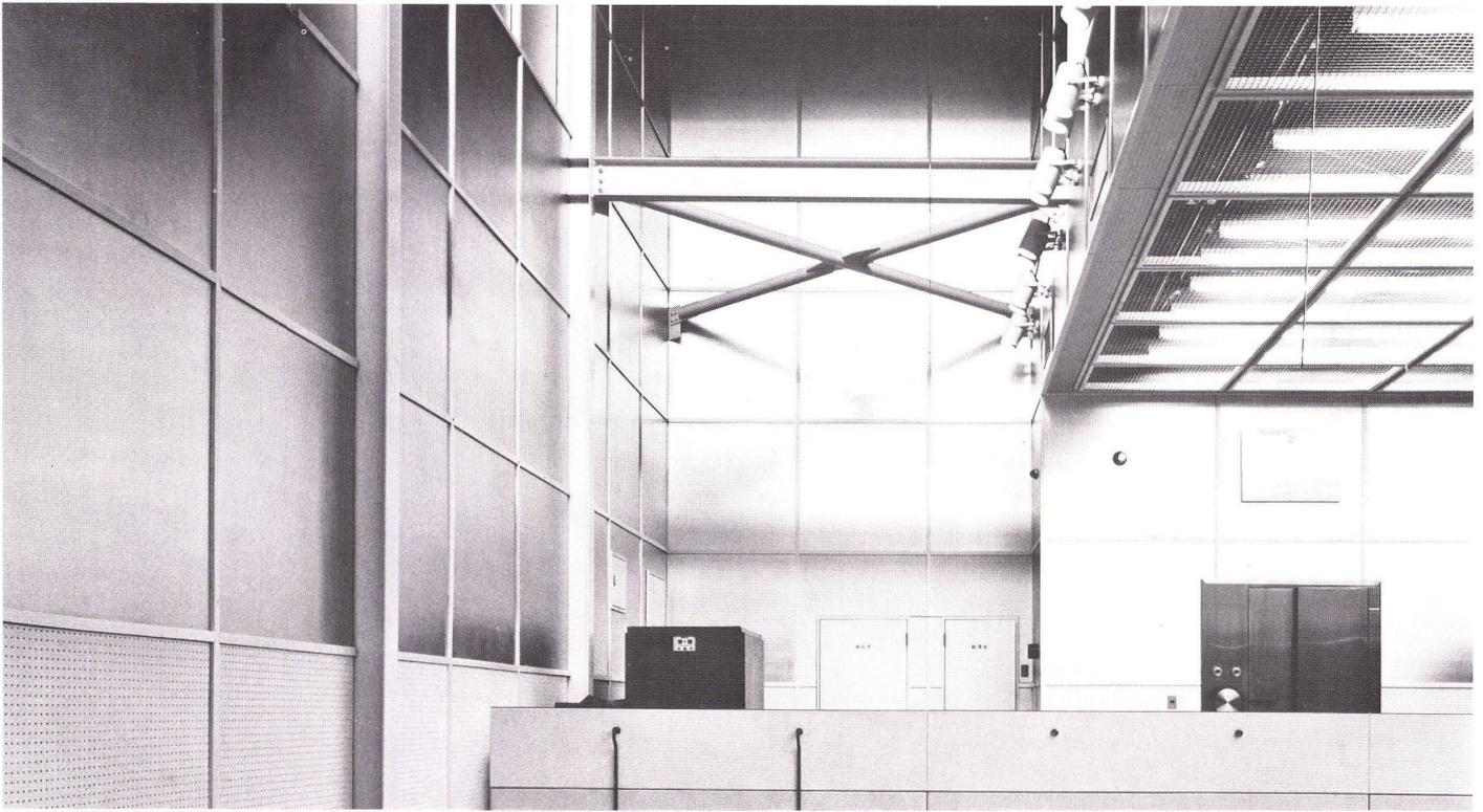
Das Home Bank Gebäude ist eine Ropponmatsu Filiale der Fukuoka Sogo Bank. Die Rohbaukonstruktion besteht aus einem Stahlgitterwerk, das mit Aluminiumplatten nach außen verkleidet wurde und innen weitgehend sichtbar blieb. Besonderes Gewicht maßen die Entwerfer den Dachabschluß- und Eckdetails zu, da sie an diesen Stellen die Konzeption der Platteneinkleidung nicht verletzen wollten. Durch den dünnen Dachabschluß und die runden Ecken wurde dieser Absicht vollauf genüge geleistet.
