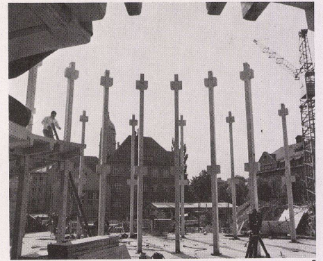
1 Mitteltrakt. Anordnung der Fertigteile. Decke über 1. OG. Aile centrale. Disposition des éléments préfabriqués, plancher haut du 1er étage. Central tract. Arrangement of prefab parts, ceiling above 1st floor.
