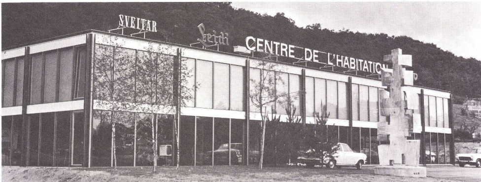
Centre de l'habitation , 2022 Bévaix NE — R. Gassmann, 2022 Bévaix
