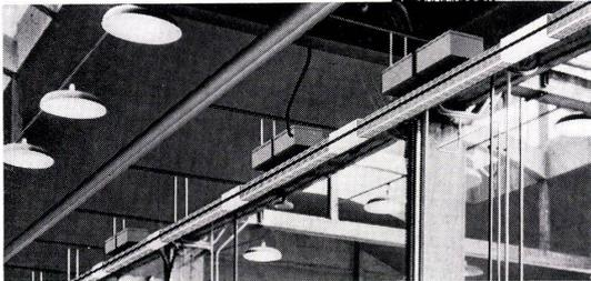
Wenn der Anschluß zahlreicher Verbraucher verlangt wird (zum Beispiel in Fabrikations-, Montage- und Maschinenhallen), dann sollte der Strom aus dem Canal verteilt werden. Aus dem «CANALIS»-Hochstrom-Schienenverteiler. Vorfabriziert nach dem Baukastensystem. Das ist wirtschaftlicher. Beweglichkeit in Produktionsabläufen und -planungen wird möglich. Umstellungen sind problemlos.
