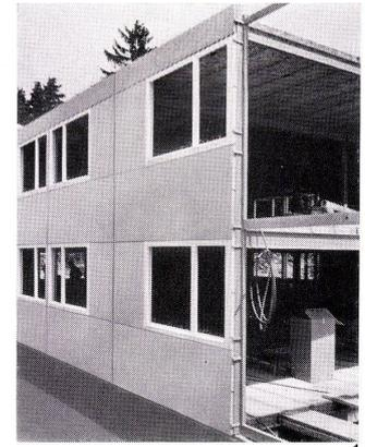
1 Montage der Außenwände aus 12 cm dicken Durisol-Fassadenplatten, die außen mit einem Zementputz versehen sind.
