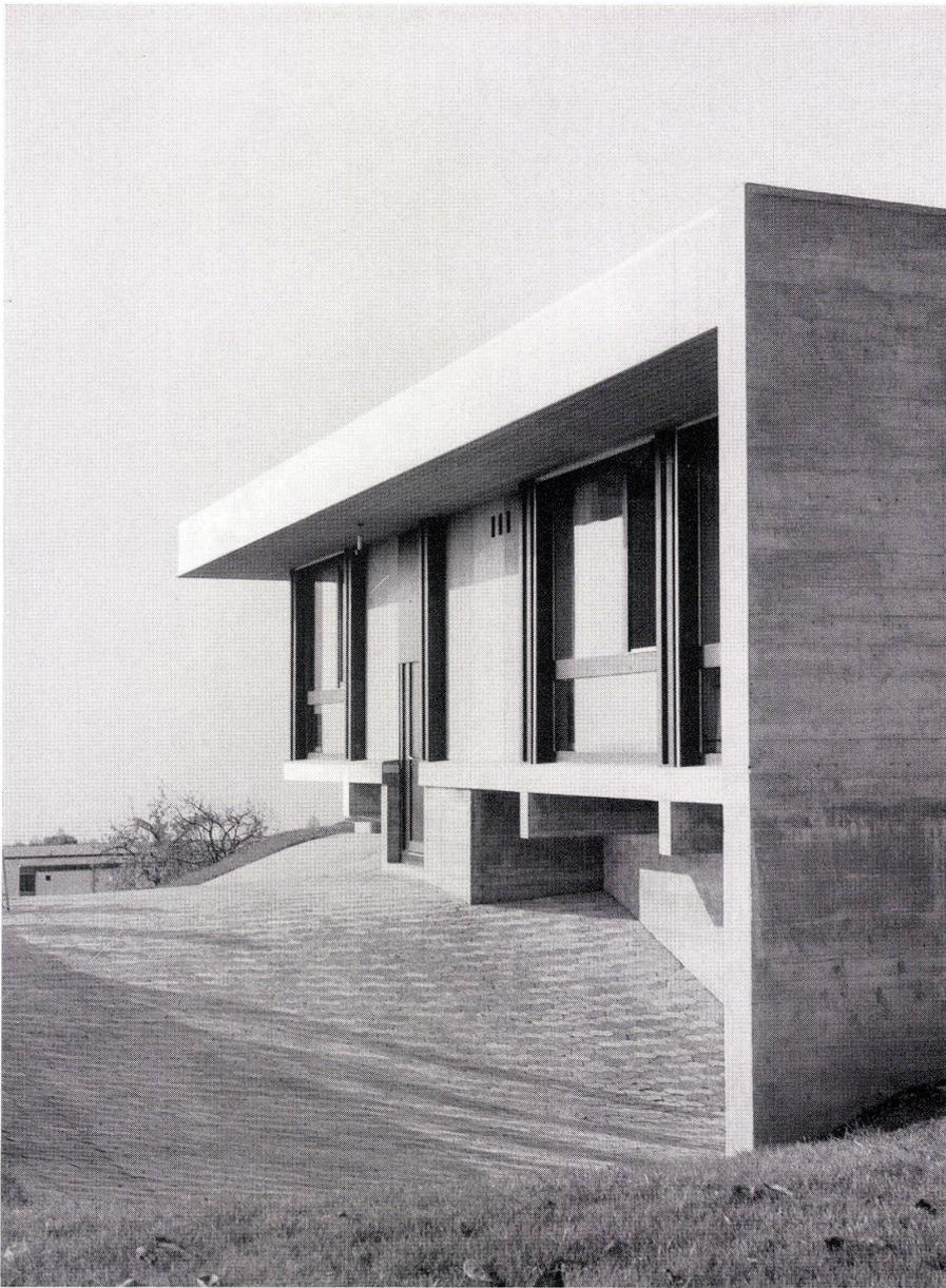
Das Erdgeschoß krägt überall über das Gartengeschoß aus, zwischen den Unterzügen unter der Gartengeschoßdecke befinden sich die Fenster für dieses Geschoß.
