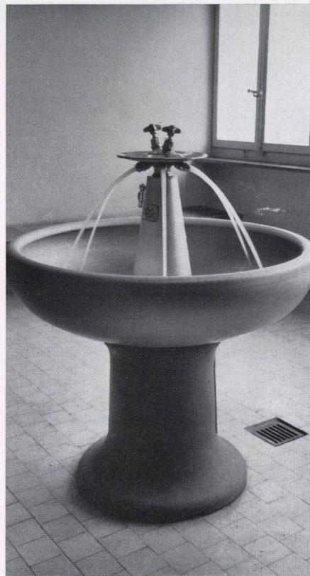
Kuhn-Sanperla-Fontäne im Neubau der Allega AG, Zürich, mit Peraluman-Bassin mit Spritzrand, Armaturen säule aus Peraluman, Sockel aus Gußeisen mit Revisionstüre.
