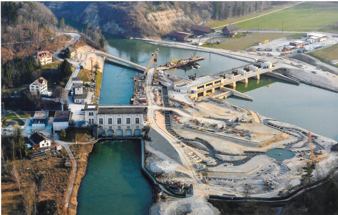
de dotation – dont le débit agit en même temps comme courant d'attraction pour les échelles à poissons –, de deux dévalaisons piscicoles et d'un bassin à dispositif de comptage en vue d'une surveillance ultérieure.
