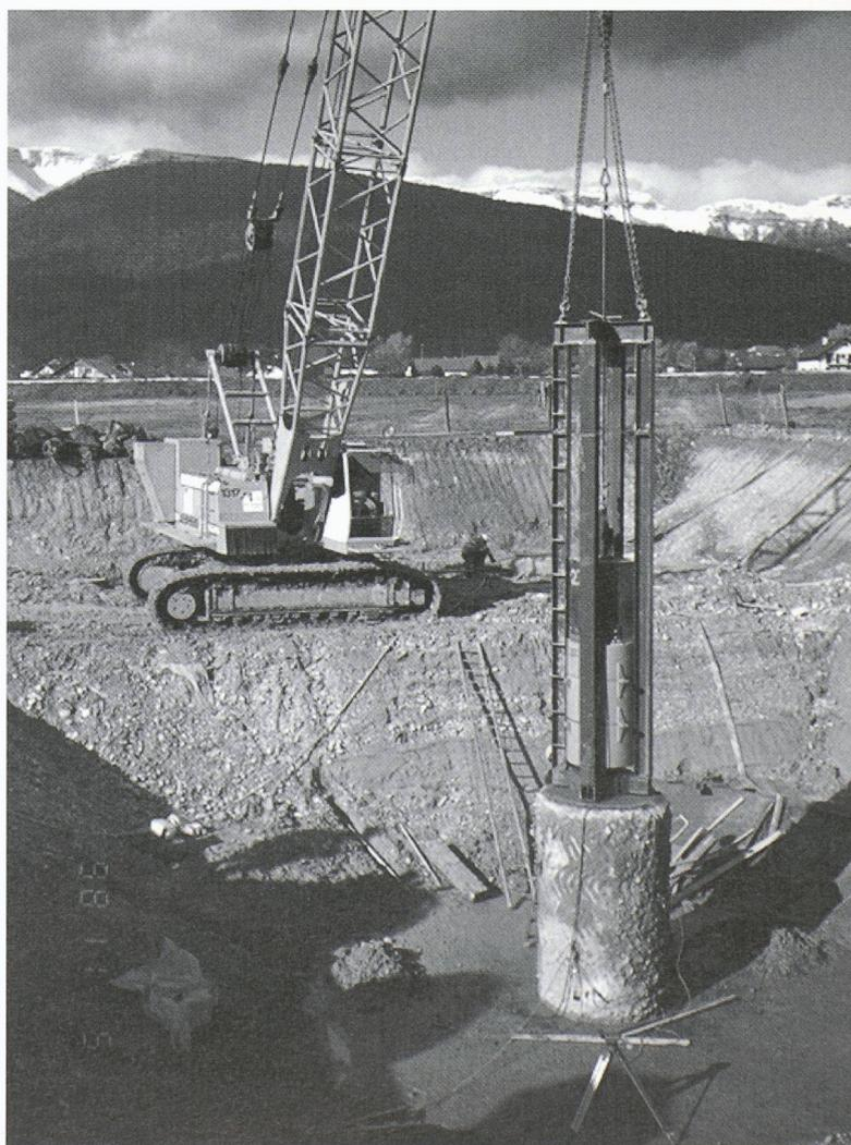
Fig. 1. Essai dynamique PDA sur pieu, diamètre 1500 mm
