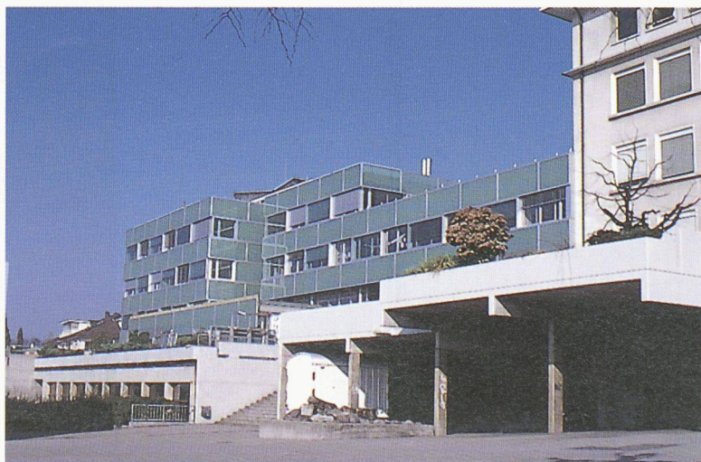
Fig. 1. L'aile ouest du collège principal de Pully, implanté dans la pente par le biais d'une succession de terrasses. (Photo bureau Devanthery & Lamunière)
