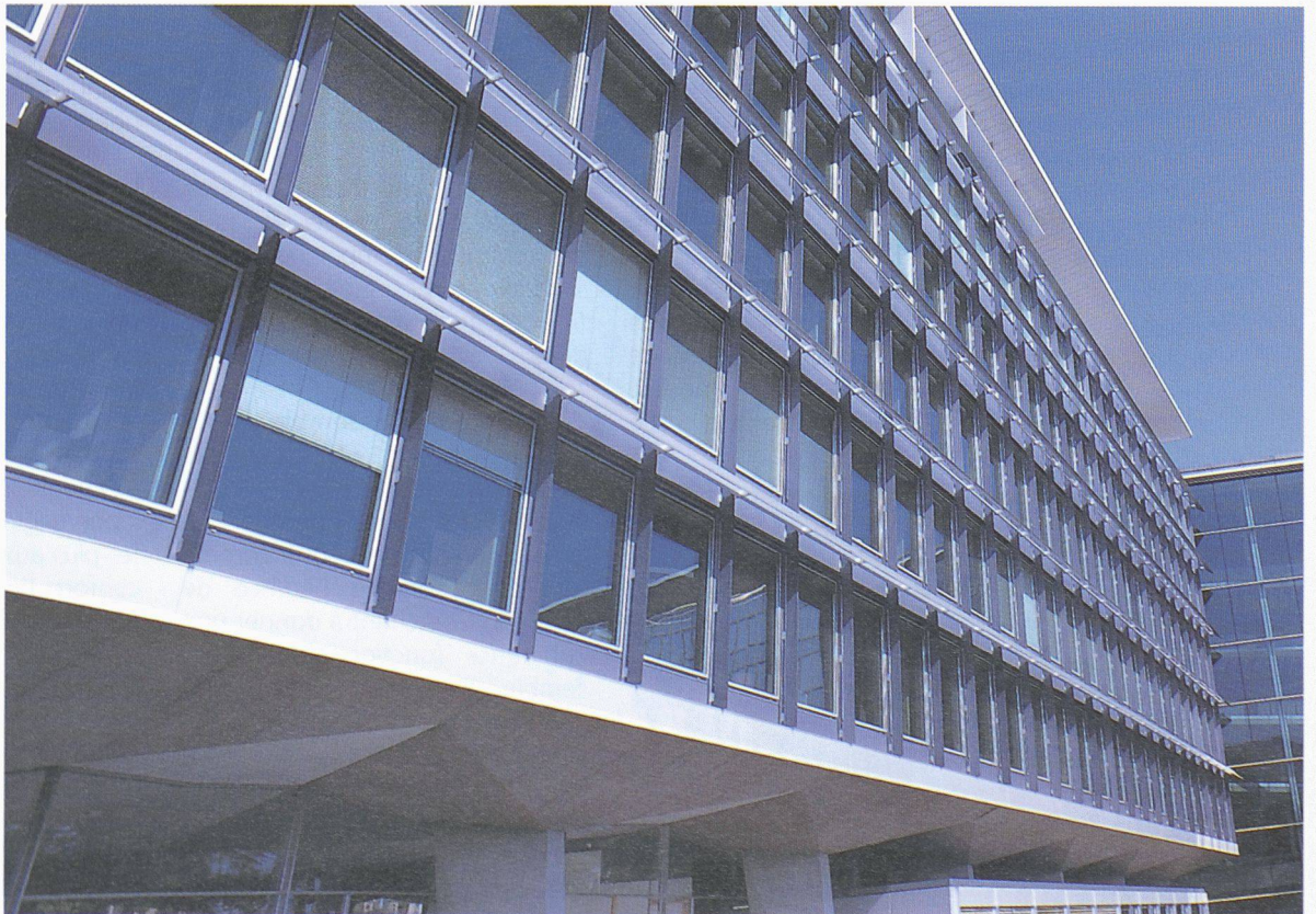
Fig. 5. Façade sud après rénovation (Photo Pierre Boss, Renens)
