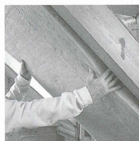
Montage du panneau ISO-TWIST
