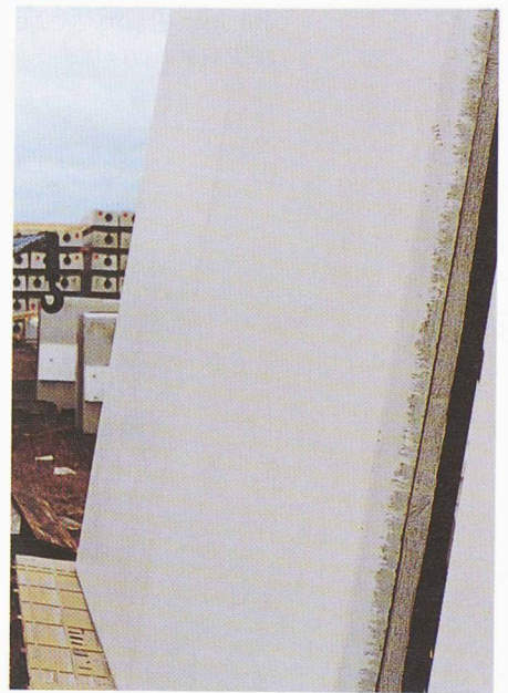
Fig. 2. – Élément préfabriqué pouvant être utilisé comme structure porteuse ou comme coffrage perdu dans la partie arrondie de la section du tunnel
