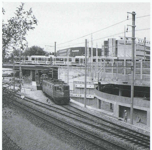
Avant (à gauche): tout le trafic entre le triage de Muttenz et le Dreispitz était en conflit avec le trafic routier et deux lignes de tram sur la route de Münchenstein. Après (à droite): le tunnel du Schwertrain permet l'accès direct à la ligne Bâle-Delémont sans interférence avec la route.
