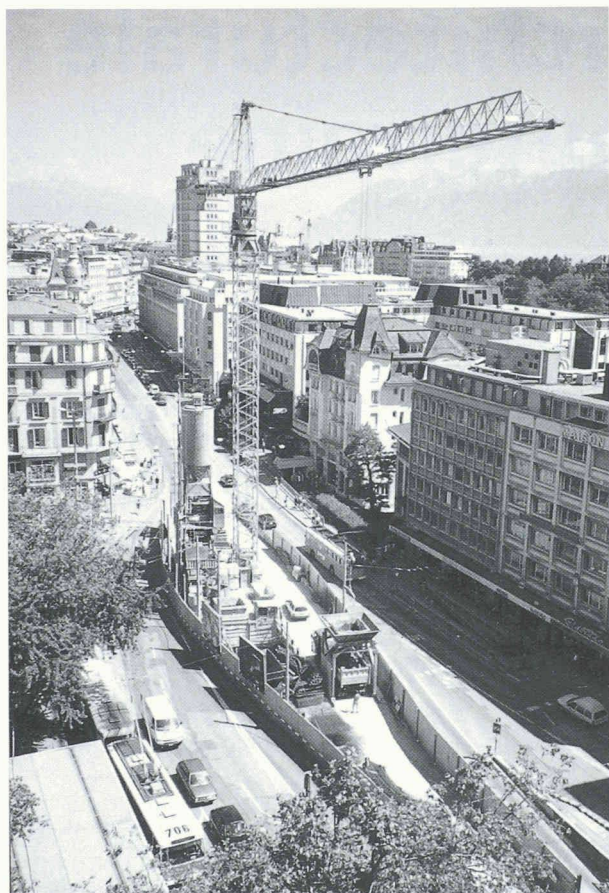
Fig. 16. – Place Chauderon: installations de chantier
