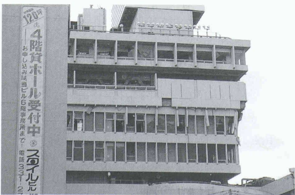
Fig. 17. – Effondrement d'un étage intermédiaire presque sans aucun déplacement horizontal
