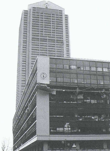
Fig. 15. – Bâtiment de l'administration communale avec un étage intermédiaire effondré
