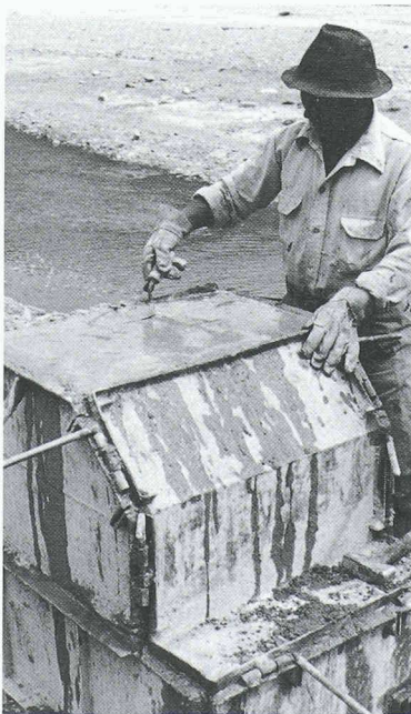
Fig. 12. – Un bloc vient d'être coulé
