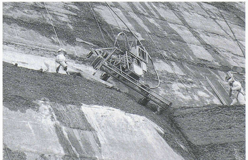
Fig. 5. – Robot d'hydrodémolition. La tringle de guidage de la lance est bien visible.
