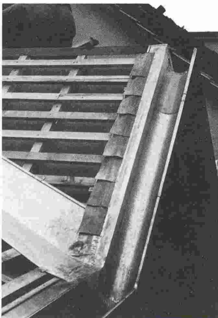
Quand on aménage des combles, il faut le plus souvent refaire aussi la ferblanterie.
