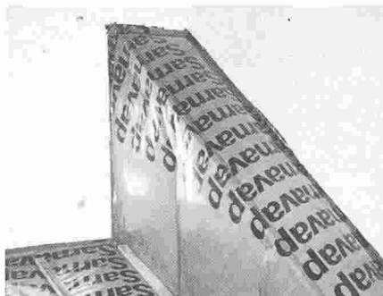
Pose après-coup de la barrière de vapeur (ou du pare-vapeur) raccordée de l'intérieur et de manière étanche à l'air.
