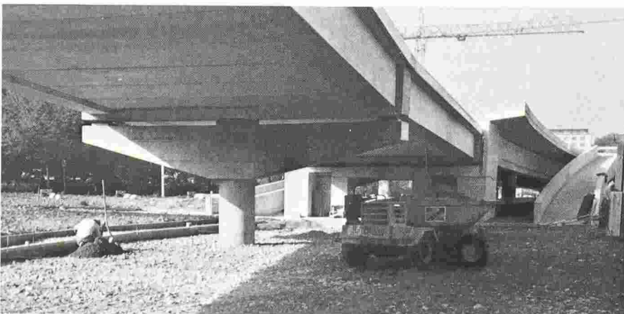
Fig. 12. - Le viaduc de Sévelin (au premier plan) et la station en pont de Montelly reposent sur une culée commune.
