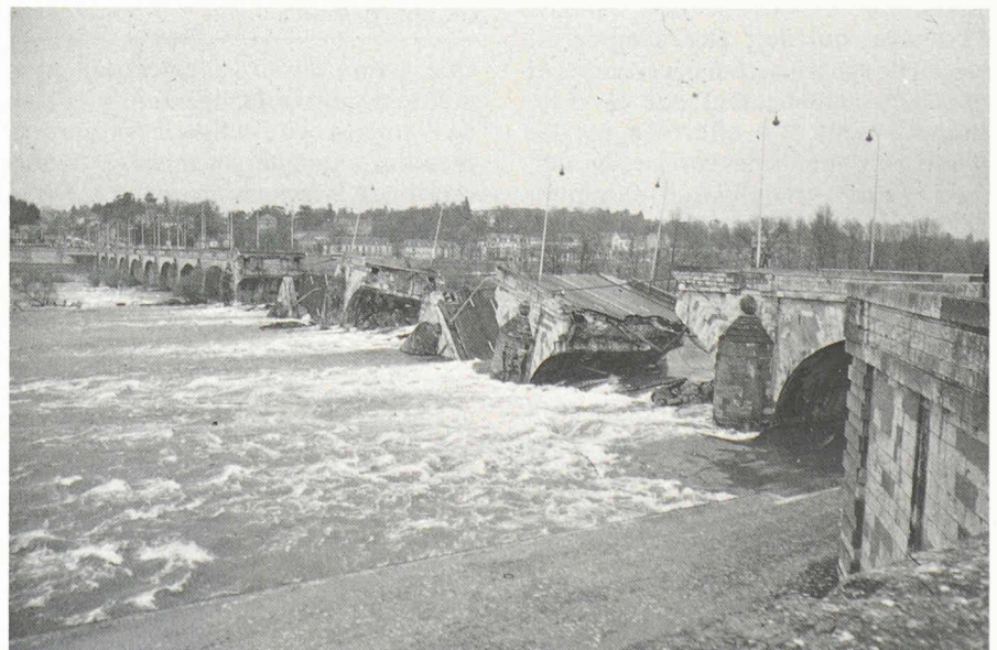
Fig. 17. – Effondrement du pont Wilson, sur la Loire, à Tours, le 9 avril 1978 : le niveau du fond du lit du fleuve s'est progressivement abaissé, notamment à la suite des extractions de sable effectuées en aval (même très loin).
