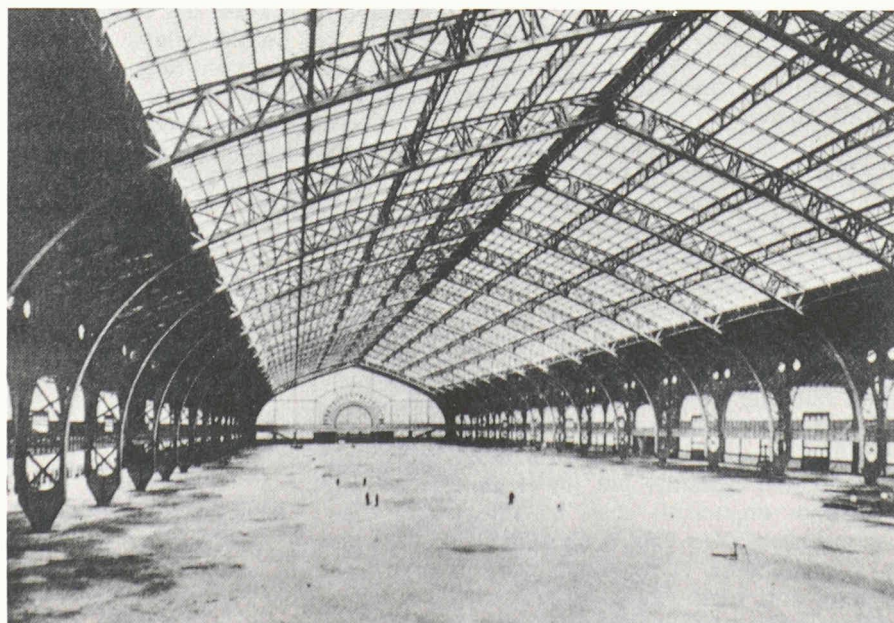
Halle des machines à l'Exposition universelle Paris, 1889. Architecte : L. Dutert. Ingénieur : F. Contamin.
