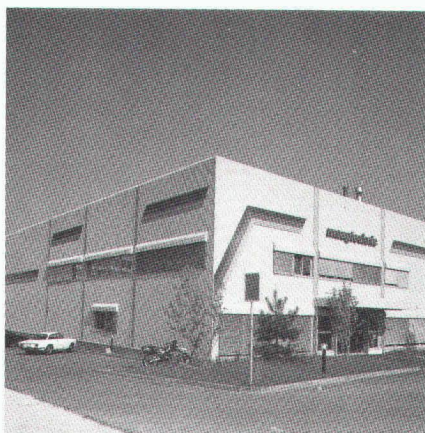
Siège romand de Maag Technic SA, Crissier
