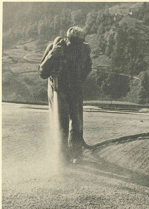
Application de béton projeté sur un ouvrage de protection contre les avalanches.
