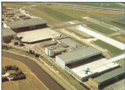
▲ Pays-Bas : Aéroport de Schiphol, Amsterdam; rénovation et nouveaux bâtiments (+ 80.000 m 2 ).
