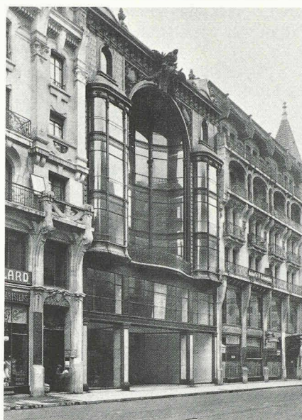
Fig. 3. — La façade à l'achèvement de la construction en 1914. On observe la recherche d'intégration voulue par l'architecte Alfred Olivet par rapport aux bâtiments adjacents.
