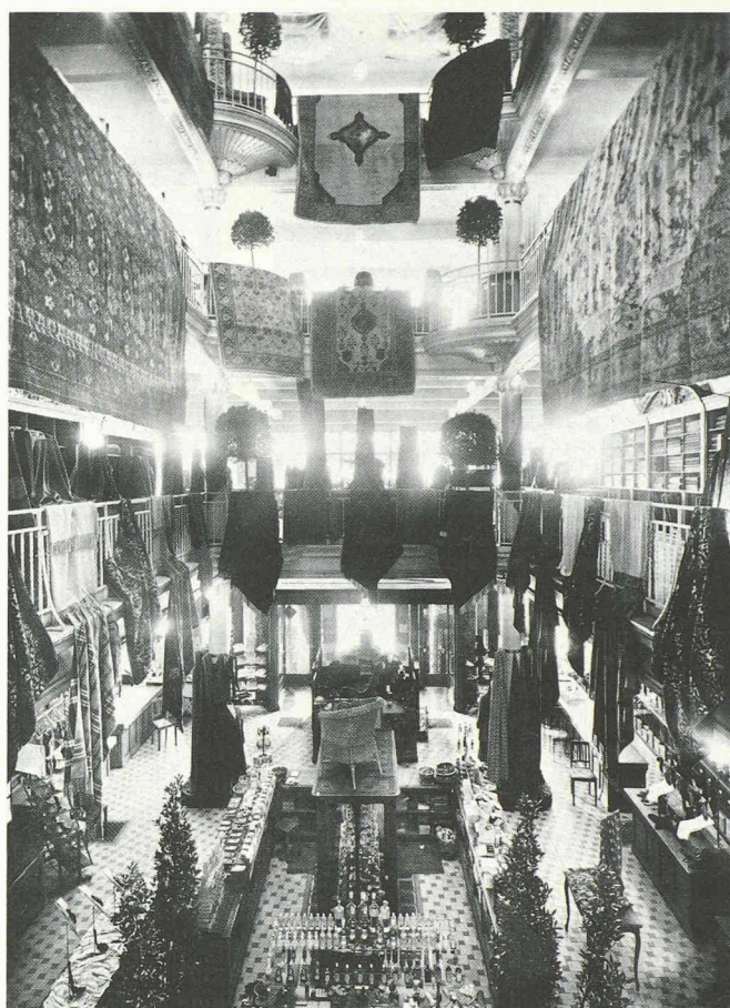
Fig. 10. — Vue des galeries en exploitation, août 1921.
