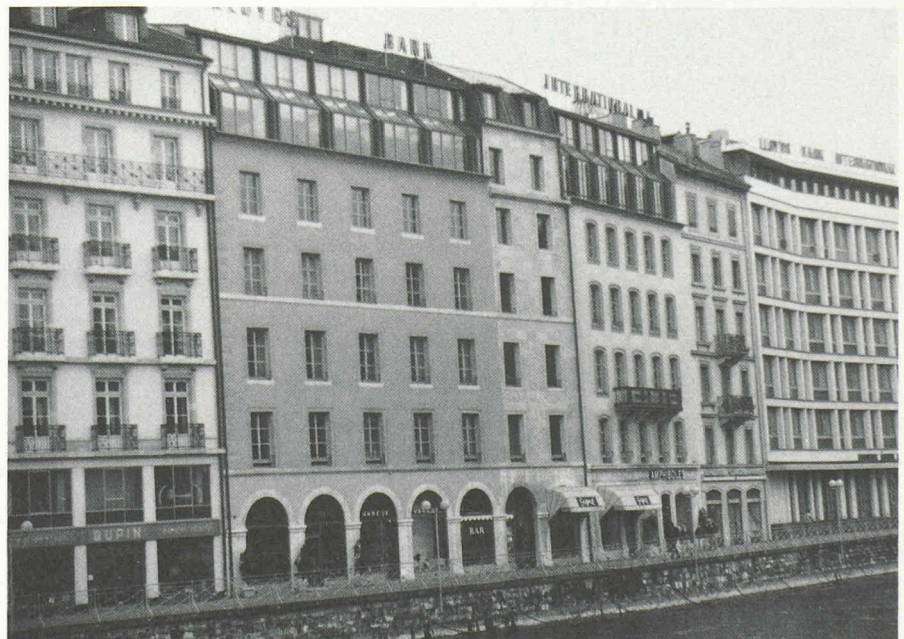
Fig. 6. — Surélévation du bâtiment de la Lloyds au quai Besançon-Hugues.
