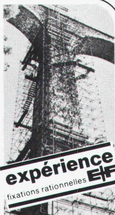
Fixation d'un coffrage
