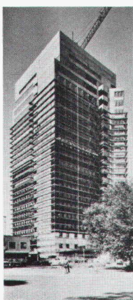
Revêtement de façade
