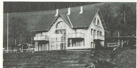
2312 Gümliigen 1984 Einfamilienhaus Furrer, Arch. Althaus Jürg
