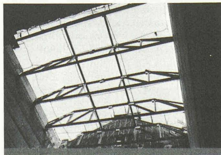
3198 Bern Altstadt 1903/1982-84 Stadttheater, Kornhausplatz 20, Arch. v. Wurstemberger, Renovation und Umbau Spörri & Valentin, Ing. Weber + Brönnimann
