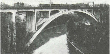
3091 Bern 5, Lorraine 1937-41 Eisenbahnbrücke, Ing. Bühler Adolf
