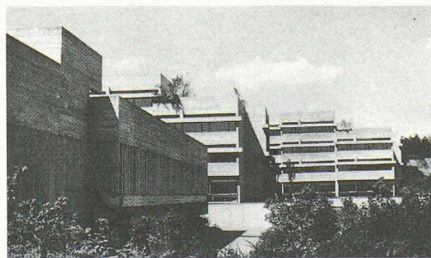
2422 Zollikofen 1962-66 Schulhausstrasse 30, Arch. Mäder und Brüggemann
