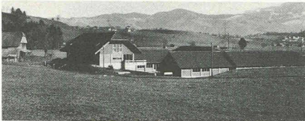
0240 Reutigen 1980/81 Kant. Fischzuchtanstalt, Arch. Baeriswyl Pierre
