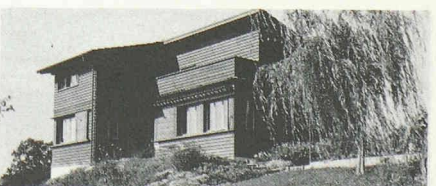
2100 Bolligen 1934 Einfamilienhaus, Arch. Jenny M.
