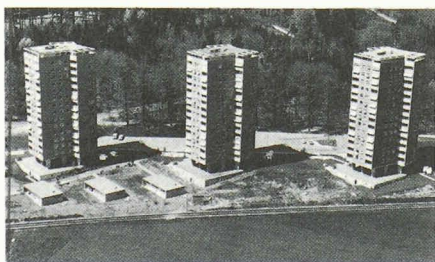
3140 Bern 3, Fischermätteli 1960-62 3 Hochhäuser, Holligenstrasse, Arch. Althaus Willy
