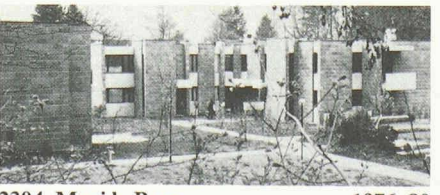
2304 Muri b. Bern 1976-80 EFH-Parksiedlung Villette, in verdichteter Bauweise, Arch.gem. Hostettler Hans, Stukky Ulrich
